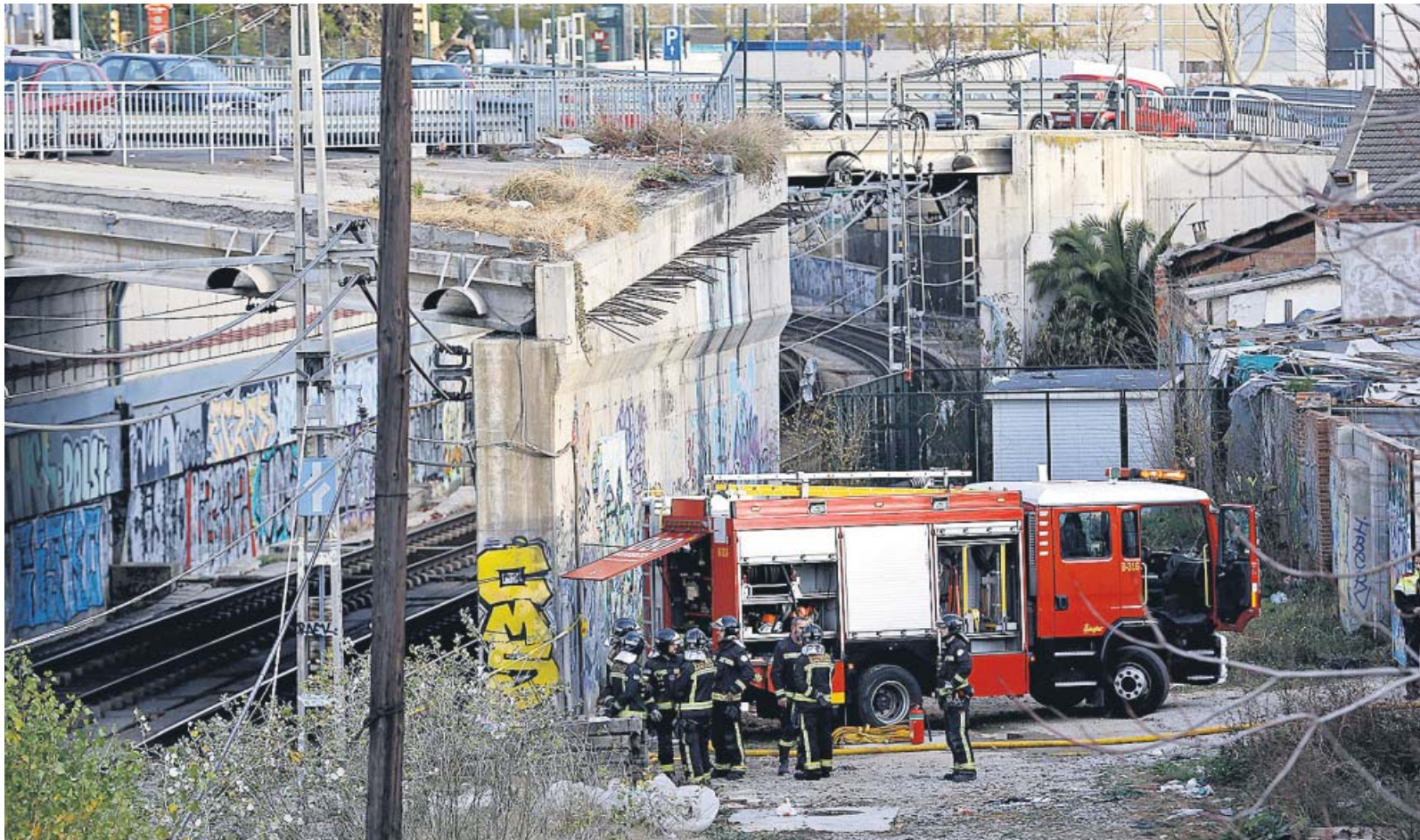
Brigadas de bomberos trabajando en las vías, a la altura de Glòries, tras el incendio que afectó ayer a la red de Rodalies. ALEJANDRO GARCÍA / EFE
