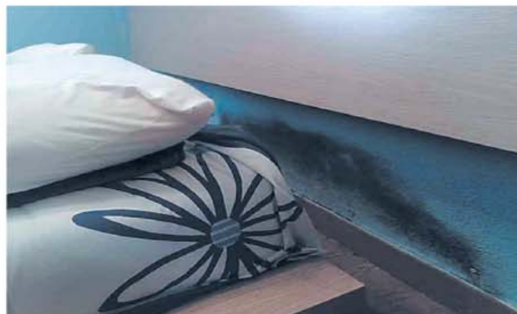
Problemas de humedades por capilaridad
