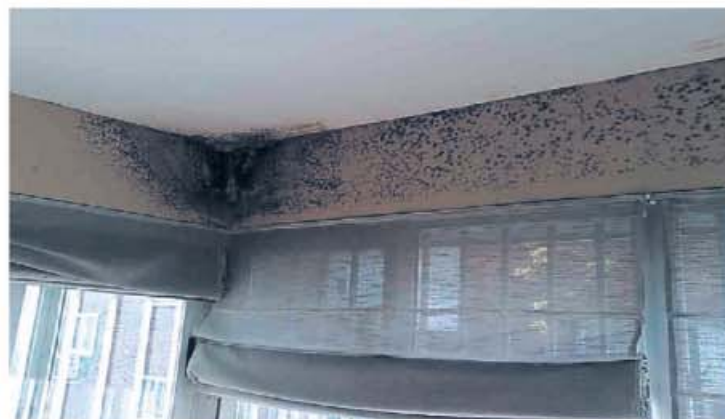
Problemas de humedades por condensación
