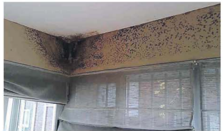
Problemas de humedad por condensación
