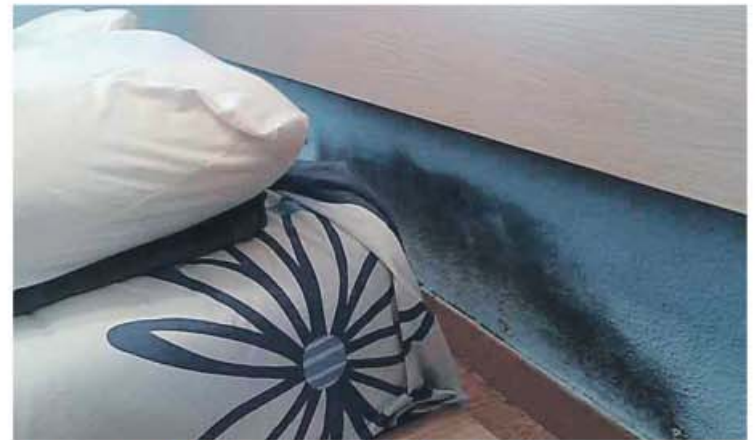
Problemas de humedad por capilaridad
