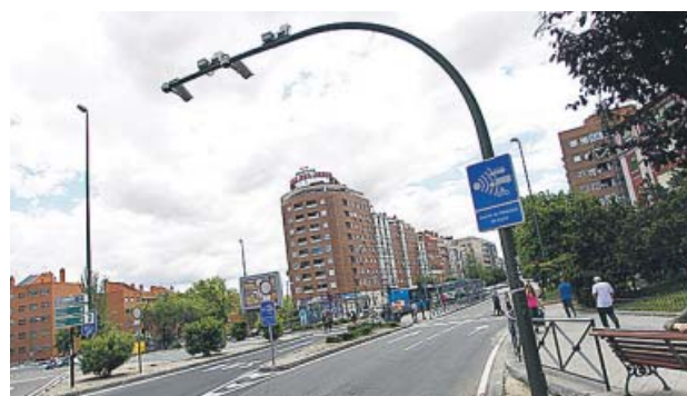
El radar de tramo, ya instalado en la avda. de Córdoba. JORGE PARÍS
