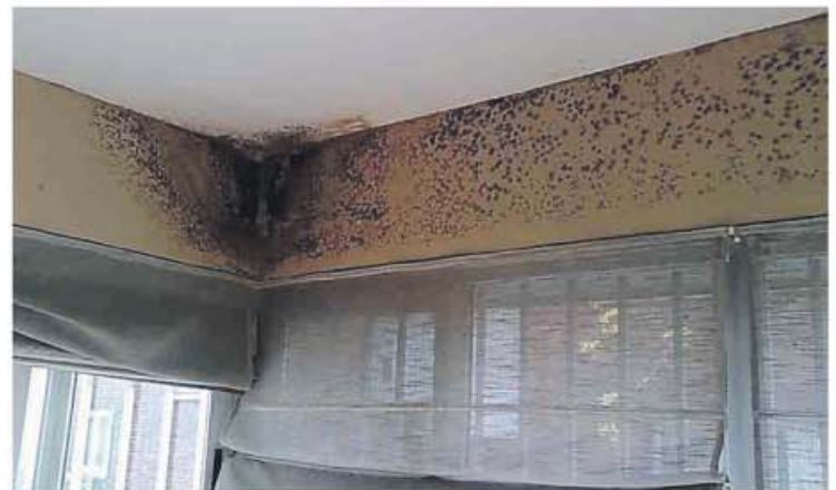
Problemas de humedad por condensación
