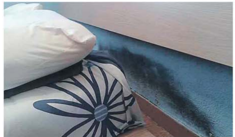
Problemas de humedad por capilaridad
