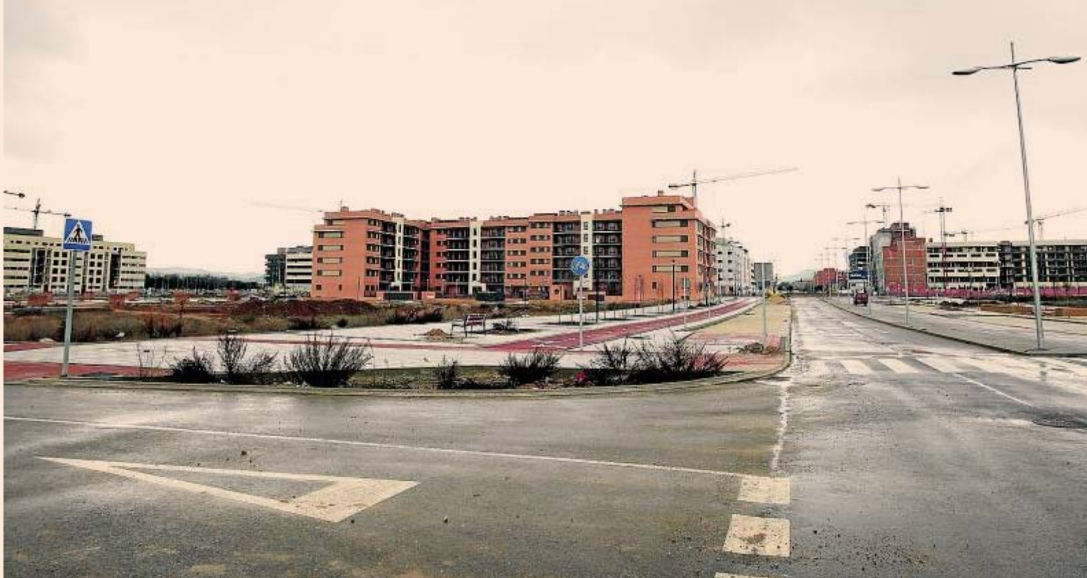
Construcción de viviendas. Los ayuntamientos reciben una parte de sus ingresos fiscales por la actividad inmobiliaria ejecutada en su término municipal.
