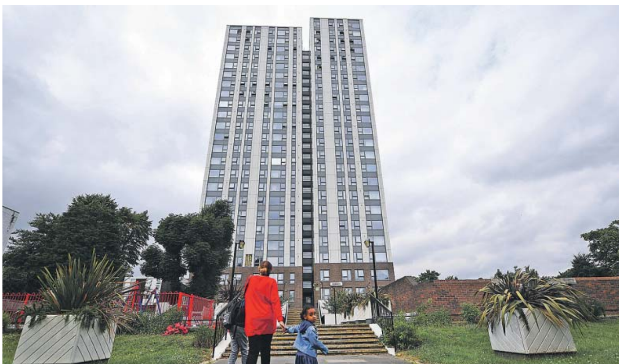
Vista de una de las torres Chalcoys en Camden, Londres, que usa el mismo revestimiento que quemó en la Grenfell. EFE
