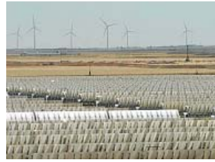
Vista de una planta termosolar.
