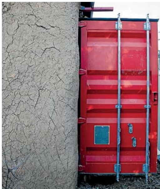
Carlos coloca la tarima flotante (izda.). A las pacas de paja que forran el contenedor (abajo) se les aplica una capa de adobe (arriba) para evitar la humedad.
