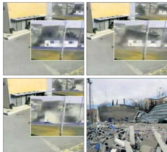
Secuencia del hundimiento del polideportivo.
