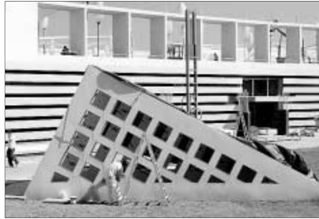
Els operaris ultimen els treballs del centre de Castelldefels. JORDI SOTERAS
