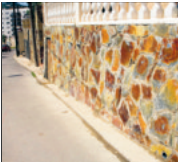
Detalle de uno de los tramos de calle sin aceras.
