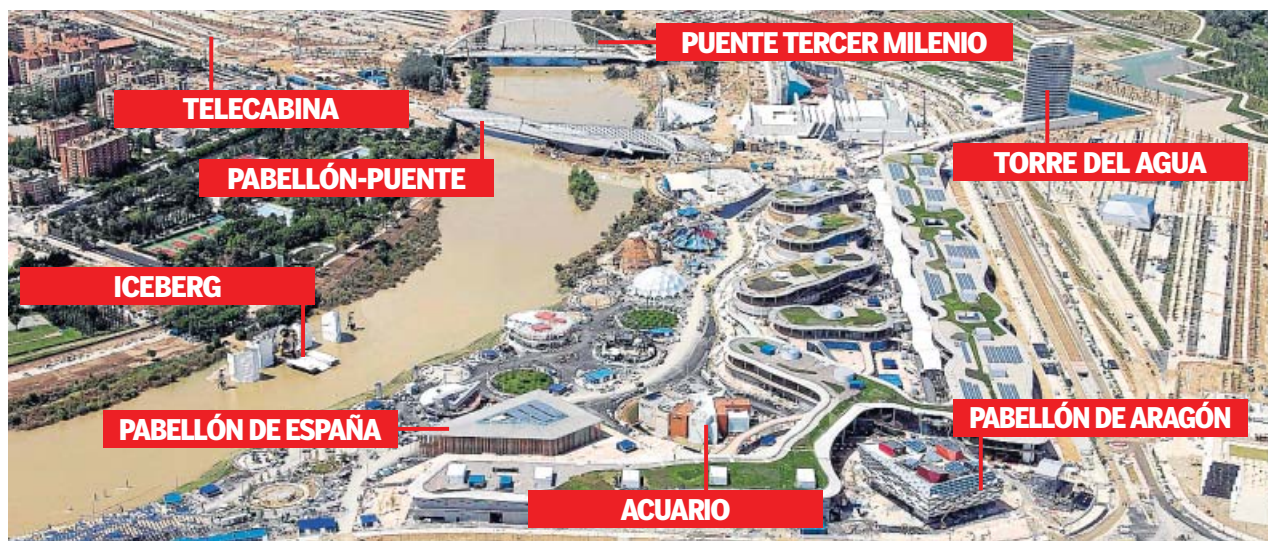
El recinto de la Expo, en una imagen aérea.
