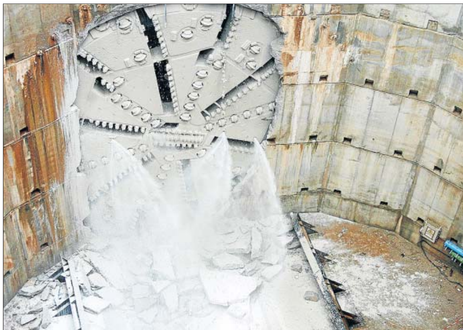
La tuneladora, anomenada La Besi, treballant en un dels trams de la futura línia 9 del metro.
