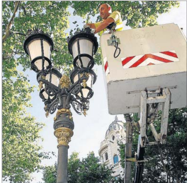
Un operari fent reparacions de danys a Canaletes, ahir. TONI GARRIGA/EFE
