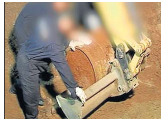
Una excavadora desenterrando el bidón en Lloret. CNP
