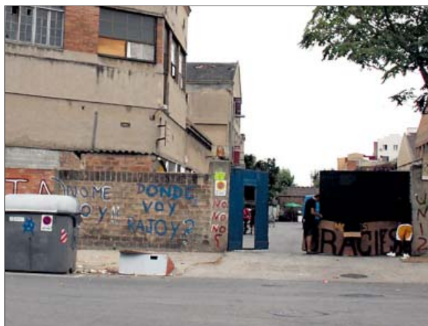
Exterior de la nave ocupada por 300 personas, ayer. GUILLEM SÁNCHEZ / ACN
