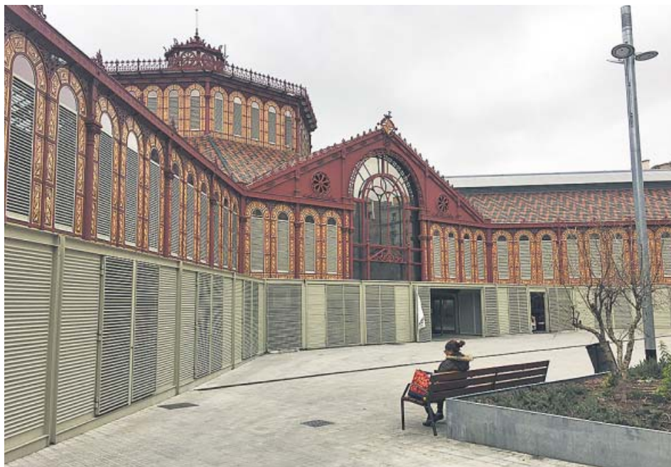
El frío y la lluvia se filtran por los ventanales del mercado de Sant Antoni. ORIOL HOSTA
