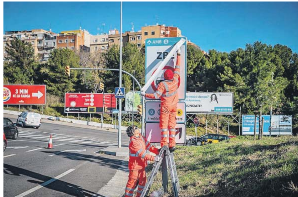
Dos operarios, ayer, instalando una señal de la Zona de Bajas Emisiones. AMB
