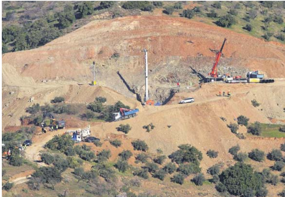
Vista general de los trabajos que se desarrollaron durante el rescate de Julen. EFE
