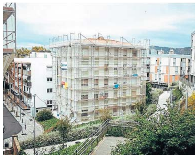
Uno de los edificios rehabilitados por el Plan de Barrios. AJUNTAMENT
