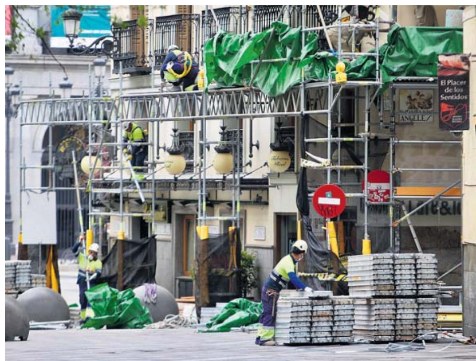
Obreros de la construcción trabajando en un céntrico edificio de Madrid. JORGE PARÍS
