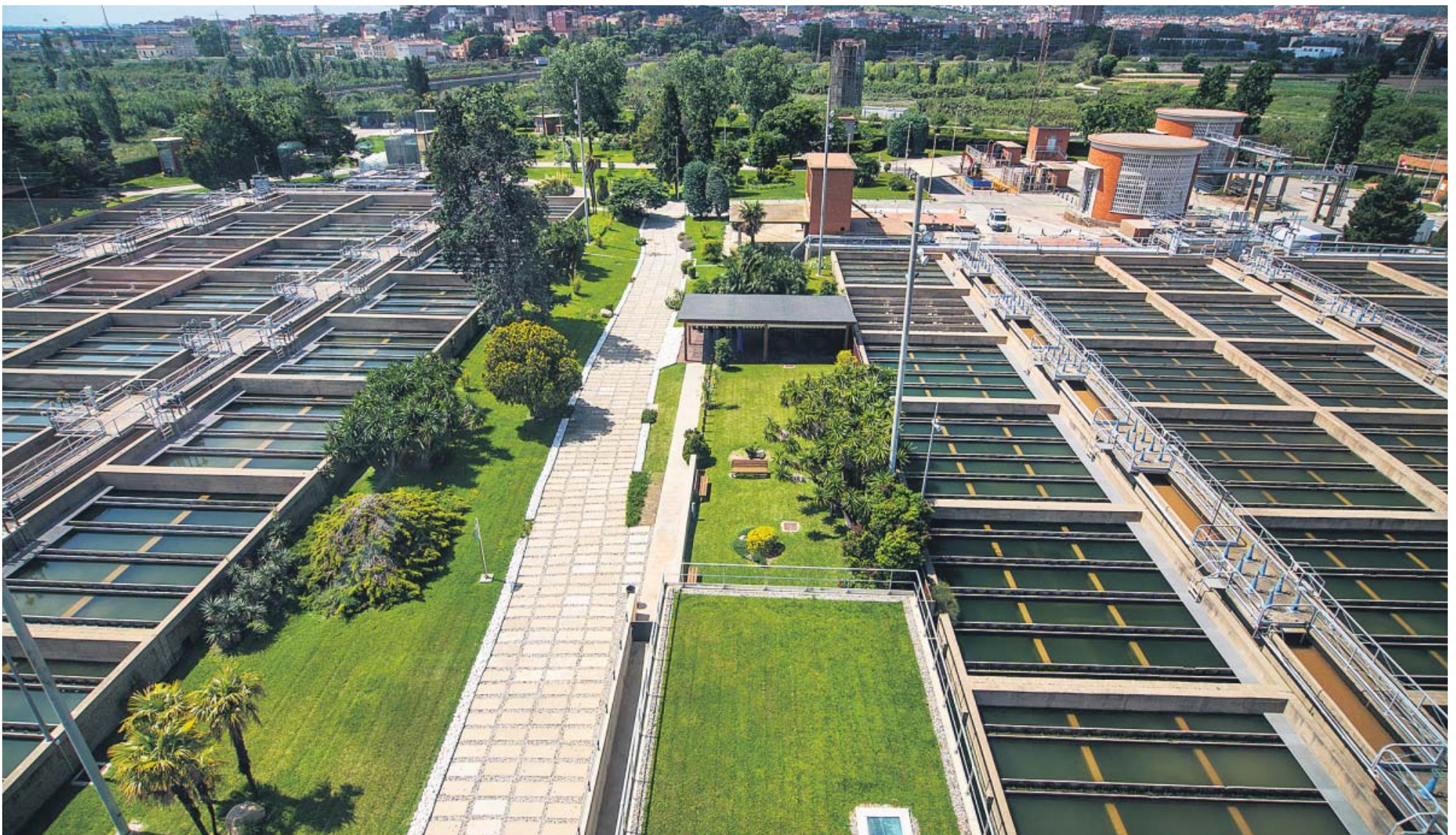
En su compromiso con el medio ambiente, Aigües de Barcelona emplea en sus instalaciones soluciones basadas en la naturaleza, como en la ETAP de Sant Joan Despí. FOTO: FERRAN MARTÍ / A. B.
