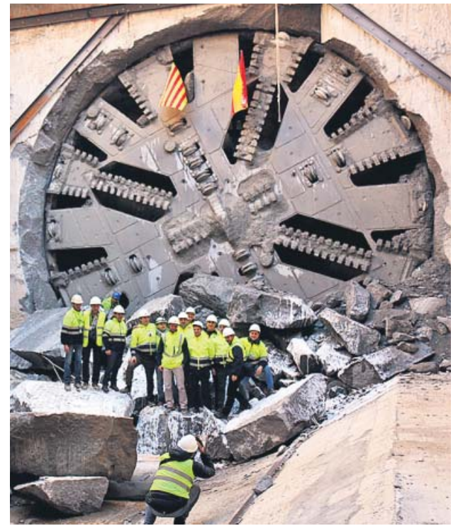
Operarios junto a la tuneladora, que acabó su trabajo en 2018. ACPN
