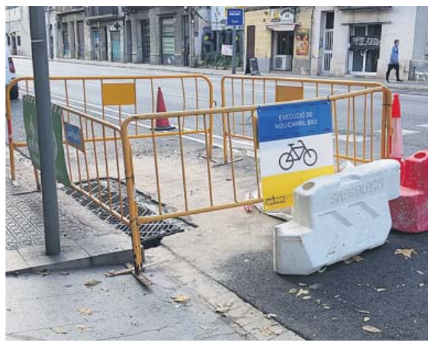
Les obres del carril bici d'Aragó a l'alçada d'Independència. I. S.
