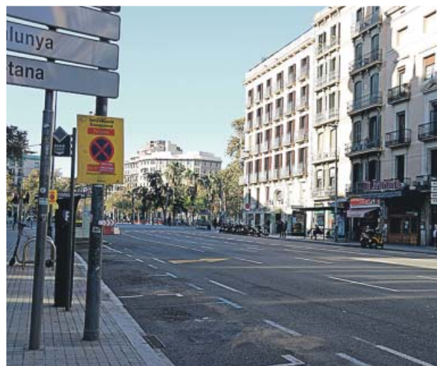
Inicio de las obras para ampliar aceras en Ronda Universitat. ACN
