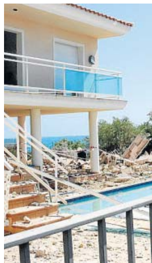
Imagen de la casa de Alcanar tras la explosión en 2017. ACPN
