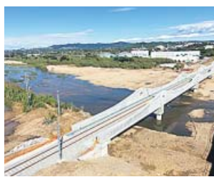
El nuevo puente construido sobre el río Tordera. ADIF
