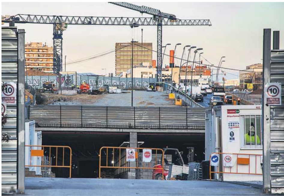
Obras del túnel de Glòries, que se prevé que finalicen en noviembre. HUGO FERNÁNDEZ
