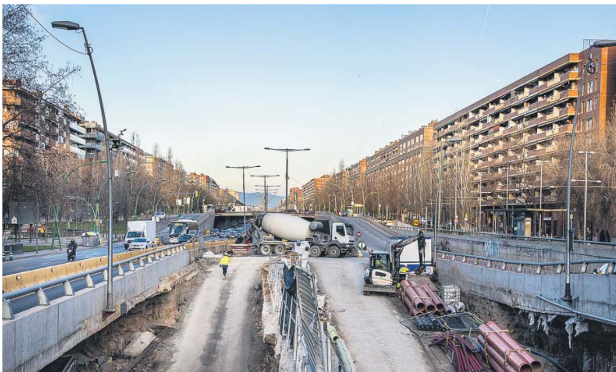
Obras del túnel de Glòries, que el Ajuntament de Barcelona prevé que esté acabado en otoño. HUGO FERNÁNDEZ
