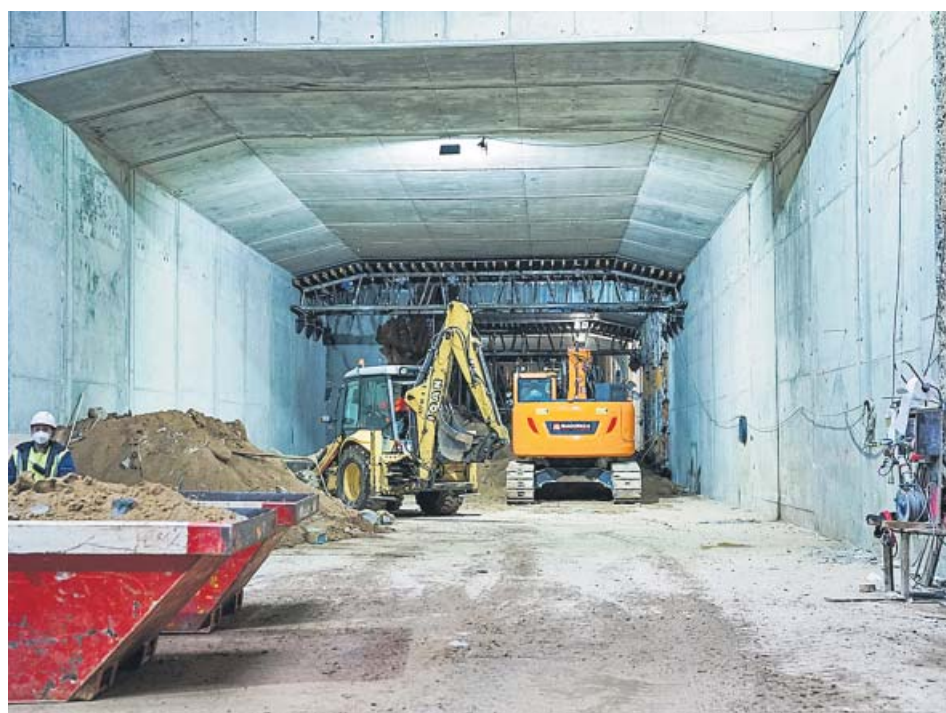
Obres d'excavació al túnel de Glòries. AJUNTAMENT DE BARCELONA
