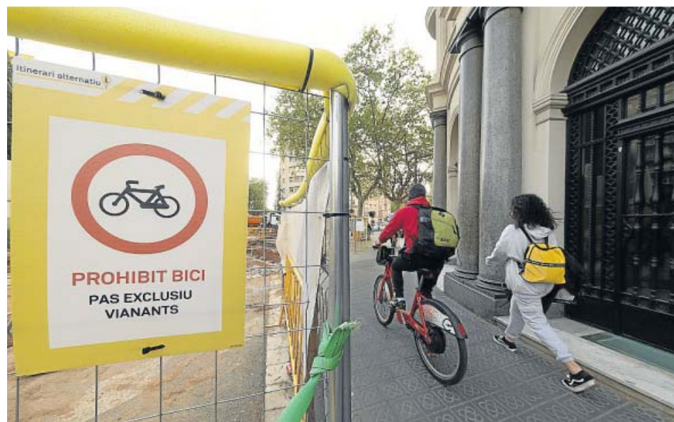
Avisos sin efecto Muchos ciudadanos se quejan en Twitter de que no se respetan los avisos que indican que los pasos entre las obras del colector son exclusivos para peatones.
