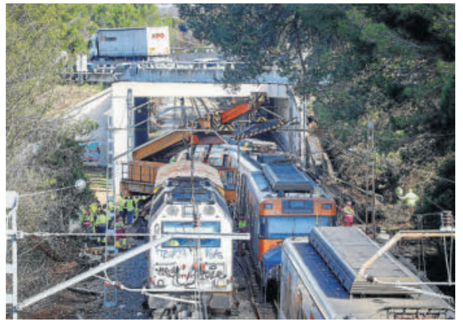
Punto del accidente de Gelida, donde ayer seguían trabajando los operarios. EP
