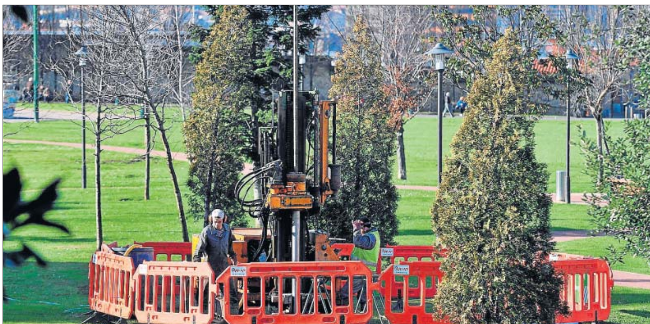
Una máquina perforadora lleva a cabo una cota en la zona ajardinada del parque, que quedará completamente agujereado.
