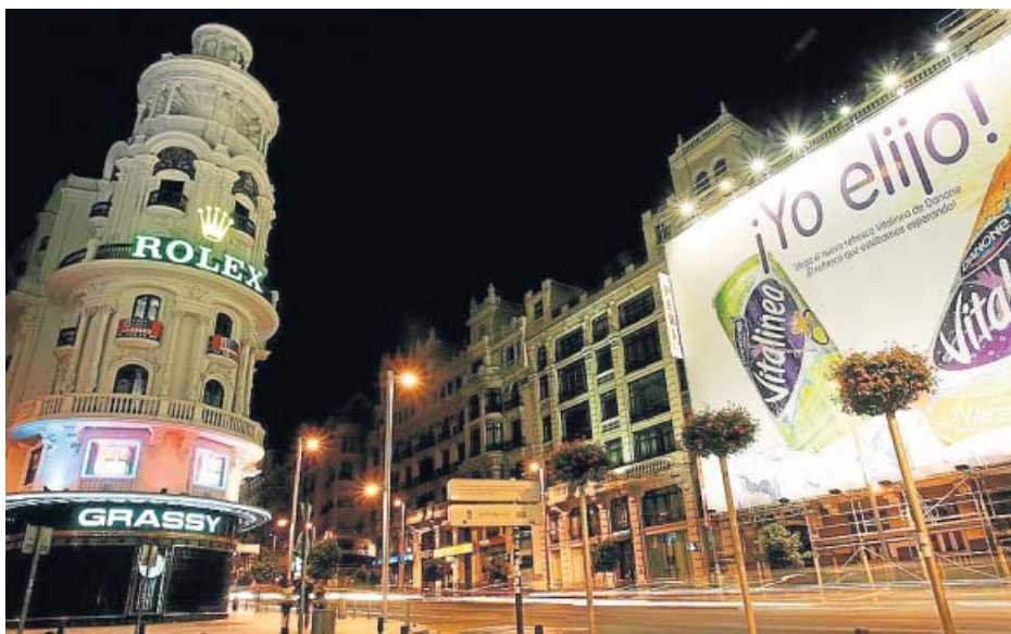
Luminoso en fachada y gran anuncio en los andamios de rehabilitación de un edificio en Madrid. ARCHIVO
