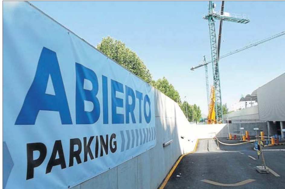
Las obras continúan en Los Mondragones mientras el parking sobre la zona de la villa ya funciona. J. A. C.
