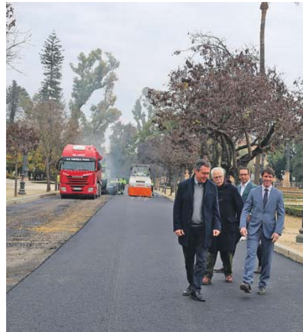
El alcalde, Juan Espadas, en una visita a las obras. AYTO. SEVILLA
