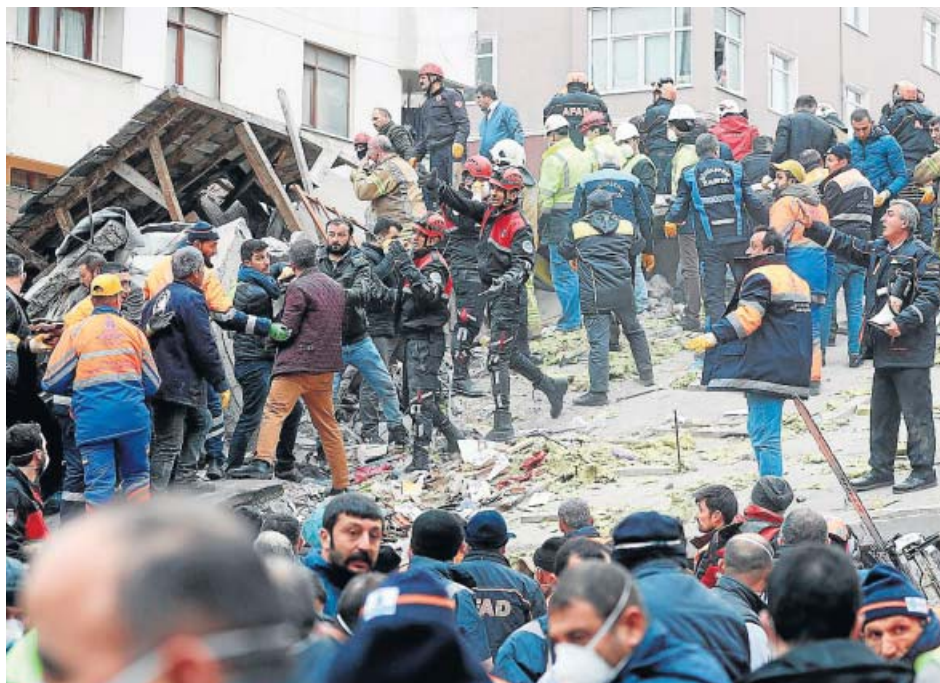
Un muerto y cuatro sepultados en el derrumbe de un edificio en Estambul. ERDEM SAHIN / EFE
