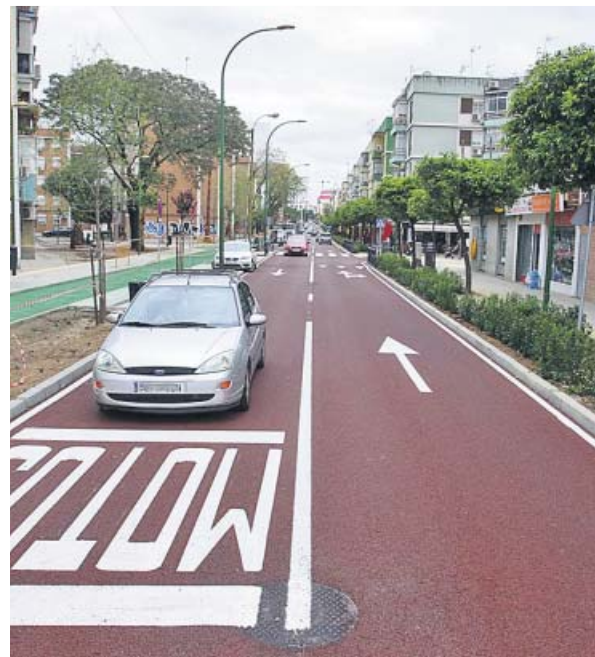
Vista de la avenida de El Greco tras la reurbanización. AYTO. SEVILLA
