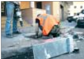
Reparan parquímetros dañados.
