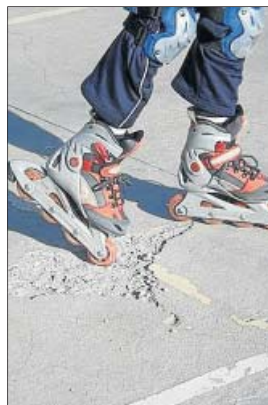
Uno de los baches de la pista de Soto. MARIBEL SANABRIA
