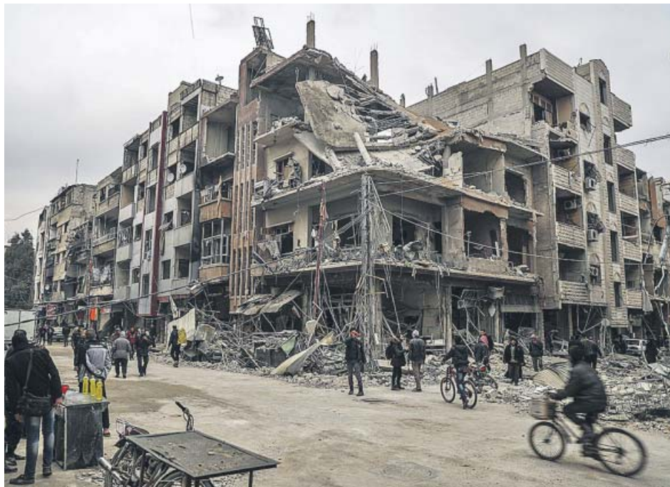
Vecinos inspeccionan edificios tras los bombardeos en Duma, feudo rebelde de Guta Oriental. EFE
