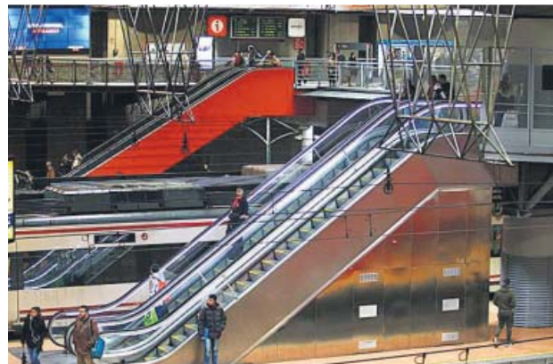
Escaleras mecánicas en la estación de Atocha. JORGE PARÍS
