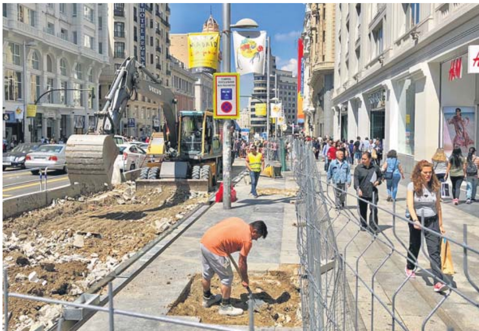
La Gran Vía, ahora en obras, formará parte de la gran APR de Centro. JORGE PARIS
