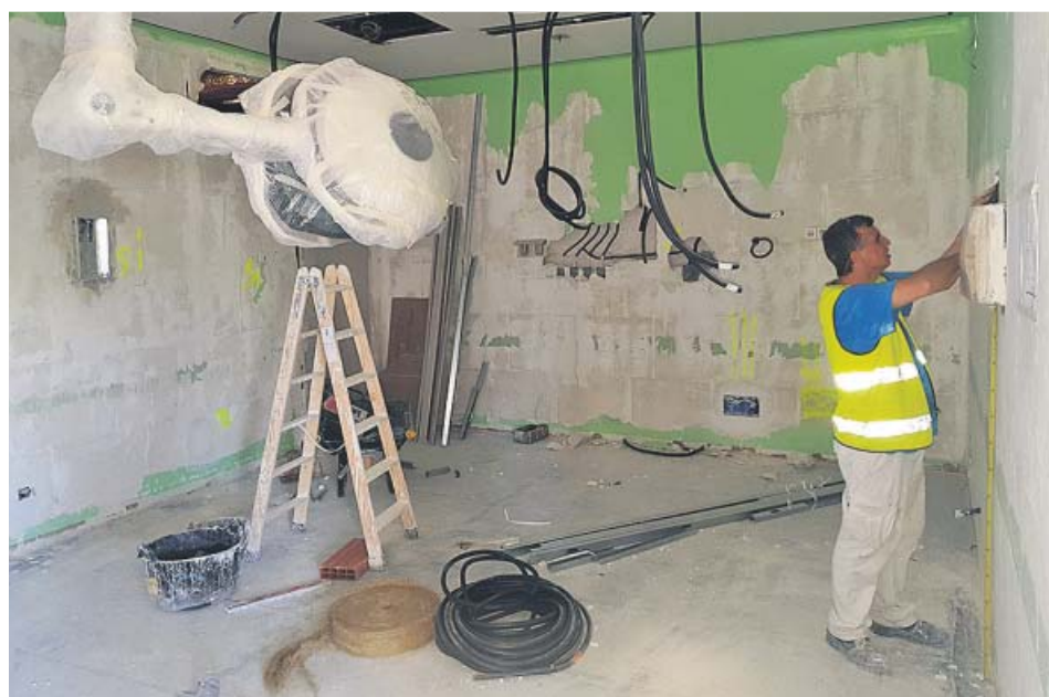
Un operario trabaja en la reforma de un quirófano en el Hospital Severo Ochoa. CONSEJERÍA DE SANIDAD
