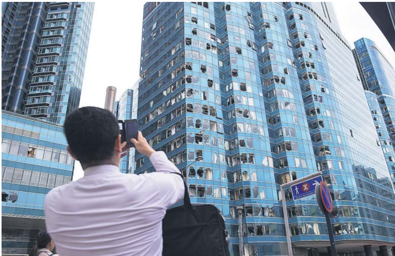
Un hombre fotografía las ventanas dañadas por el paso del tifón Mangkhut en Hong Kong. JEROME FAVRE / EFE
