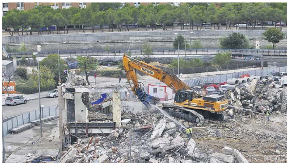
Una máquina excavadora trabajando en la demolición del estadio Vicente Calderón. JORGE PARÍS
