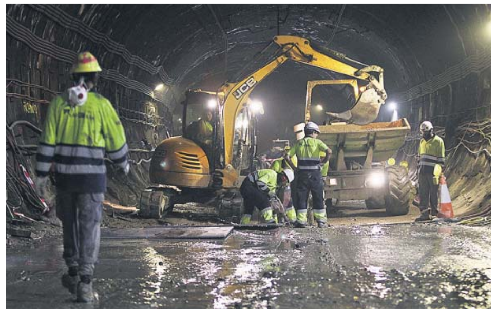
Operarios trabajando en las obras del túnel de Recoletos. JORGE PARÍS
