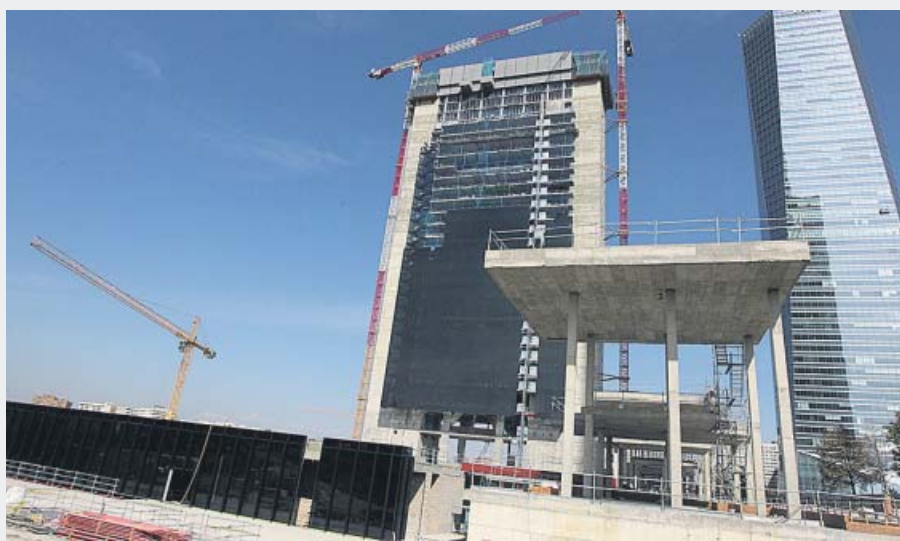
Los trabajos de Caleido avanzan a buen ritmo. JORGE PARÍS
