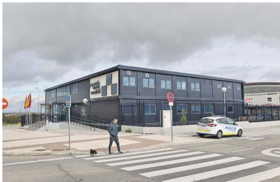
Módulo prefabricado de la Policía Municipal en el distrito de San Blas-Canillejas. JORGE PARÍS
